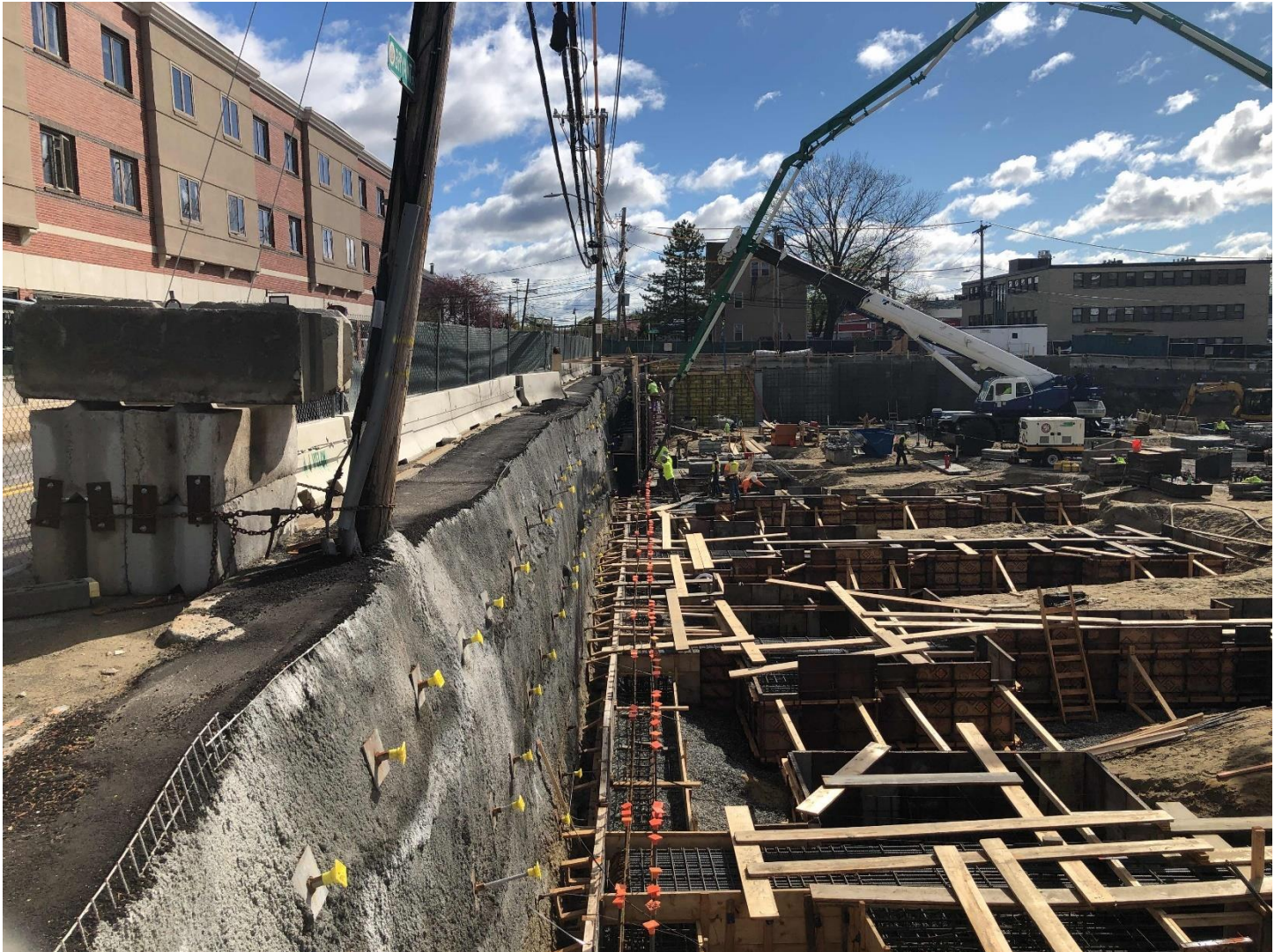
Concrete pour Garage North Wall (along Bryant)
